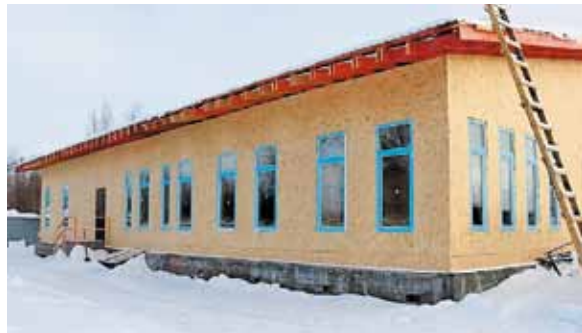
◆ Строительство культурного центра в Лайском Доке
